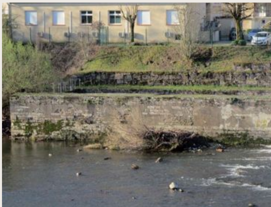
Travaux sur l'écluse
